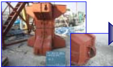
型枠組み立て(備蓄鉄筋固定)
