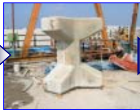
打設養生後脱型
