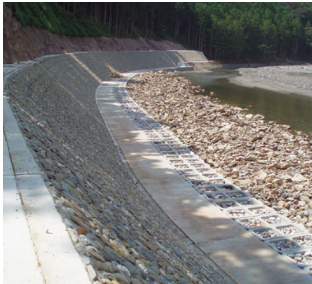
沈床バスケット(木頭護岸／徳島)
