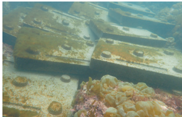
環境活性コンクリート (アワビ礁/徳島)
